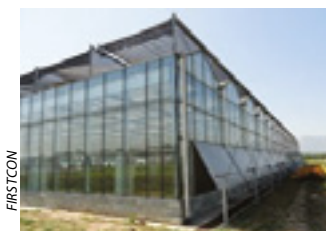
Изображение 2 Наружные затеняющие сети над покрытием
