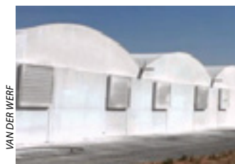
Изображение 1 Затенение теплицы путем побелки покрытия
