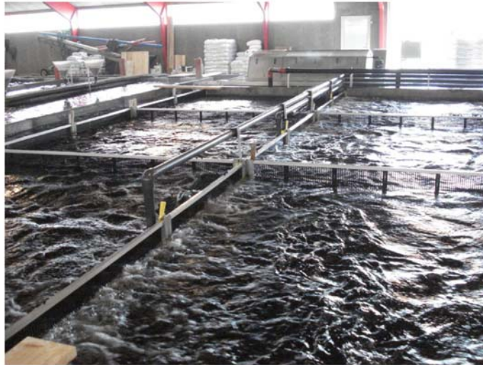
Рисунок 20_1.6 Биологический фильтр с плавающей подвижной загрузкой
