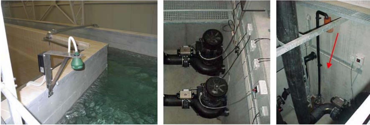
Рисунок 20_6.23 Насосы. В системе установлено 8 одинаковых насоса мощностью по 5 кВт каждый. Работают все одновременно
