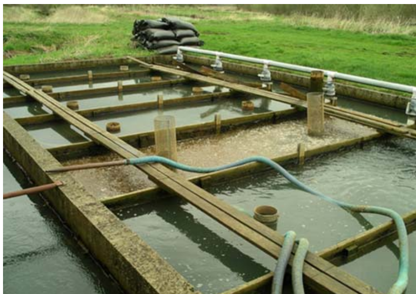
Рисунок 20_4.21 Классический погружной биофильтр в одном из форелевых рыбоводных хозяйств
