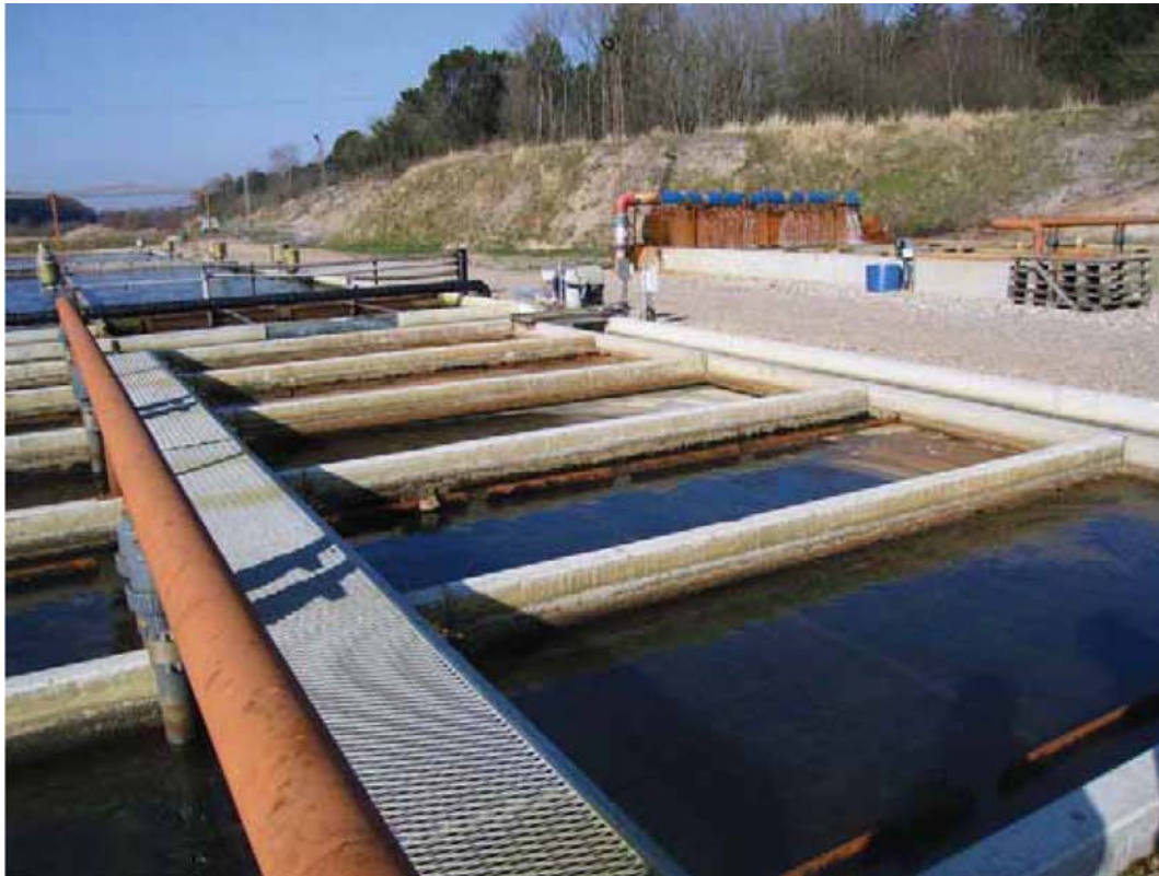
Рисунок 20_5.11 Биофильтры разделены на секции из био блоков на образцовом форелевом хозяйстве «Ejstrupholm» (тип 3). Справа от биофильтров находится охрa устройство для аэрации отведенных грунтовых вод и осадков из охры до попадания вода в производственные узлы.
