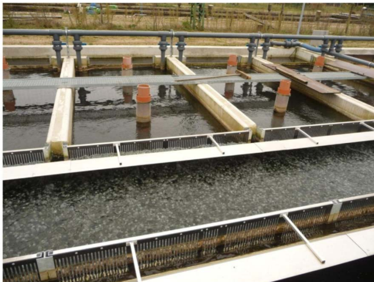
Рисунок 20_4.17 На переднем плане изображен биофильтр с плавающей загрузкой
