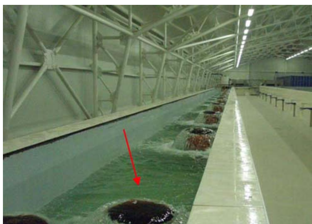
Рисунок 20_6.21 Лоток сбора воды открытого типа (бетон). Стрелкой указан телескопический слив совместно и контроль уровня воды в бассейне
