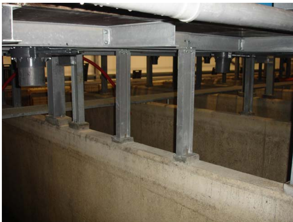
Рисунок 20_6.37 Опора второго уровня на стенки бетонных бассейнов первого уровня
