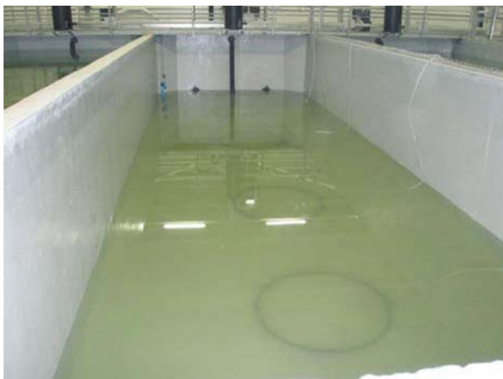
Рисунок 20_6.20 Размеры бассейна (в чистоте по воде) 3,4 метра - ширина, 10,1 м.- длинна, толщина слоя воды 1,5 метра
