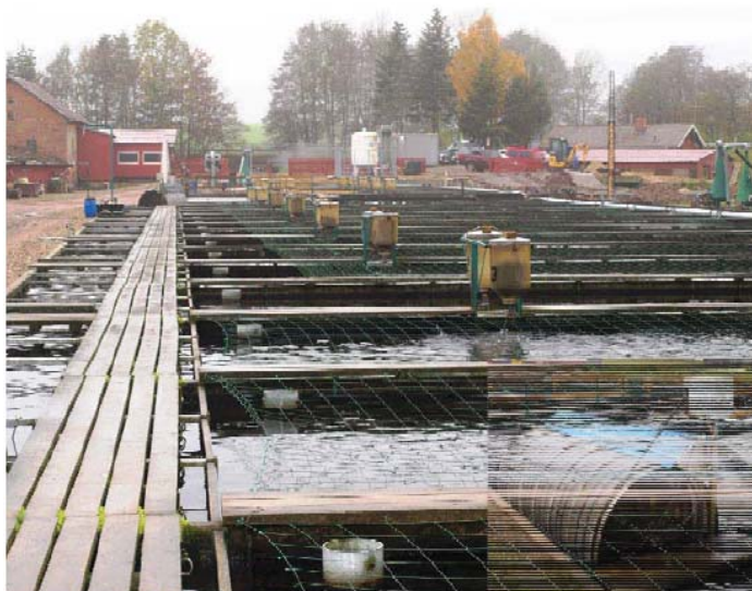
Рисунок 20_5.7 Образцовое форелевое хозяйство «Bregnholm Mølle» (тип 1) с микро ситами, вставленными в правом углу.
