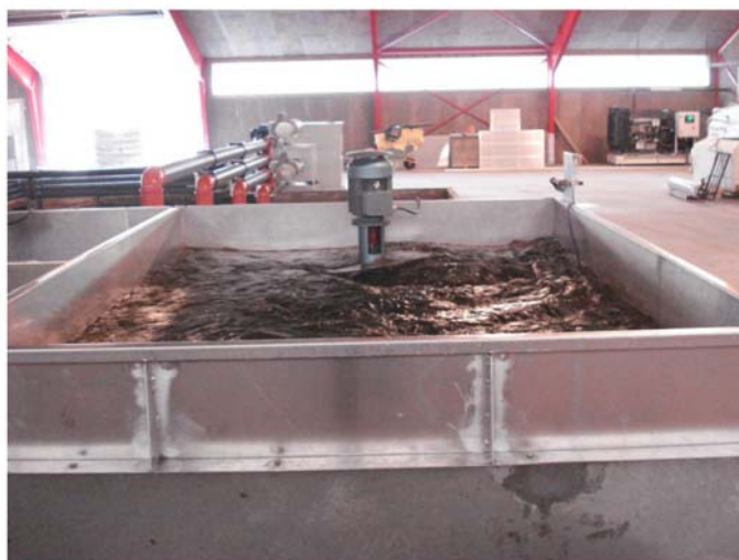
Рисунок 20_1.4 Одна из двух инжекционных платформ для добавления жидкого кислорода воду
