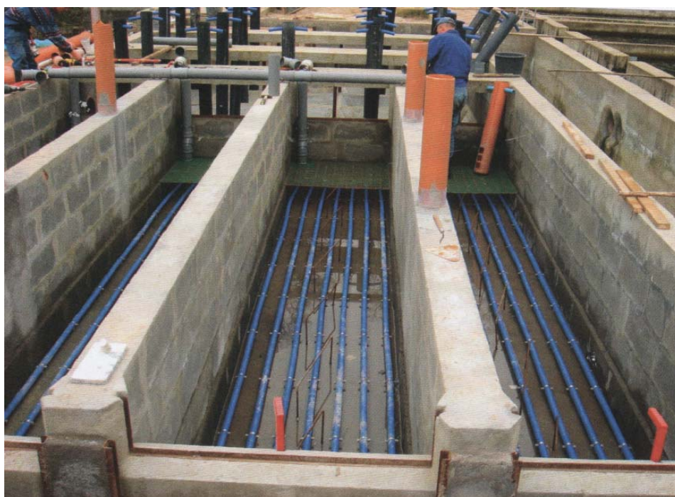
Рисунок 20_4.22 Распылители для промывки биофильтра с погружной загрузкой
