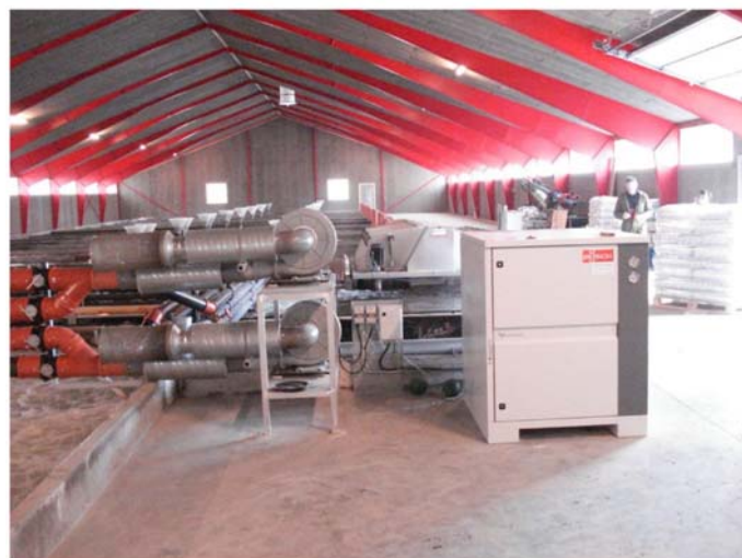
Рисунок 20_1.8 Воздуховки Capsel и Ventur для аэрации и дегазации с производительность 1500 куб. метров в час, каждая
