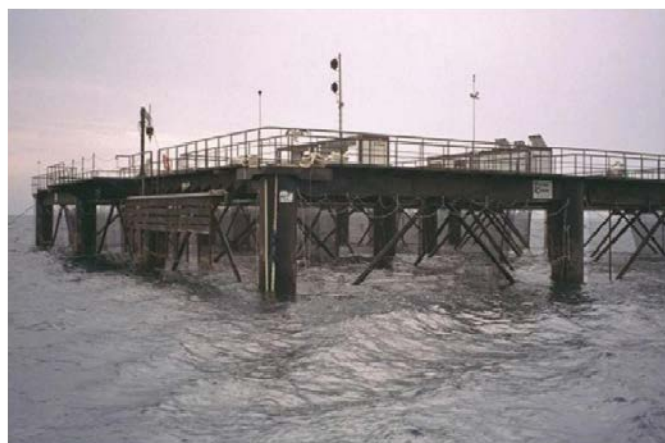
Рисунок 10.4 Фермерская система испанской компании Marina System Iberica. В Средиземном море были построены, по крайней мере, четыре системы, показанные на рисунке. На палубе имеется место для хранения корма, генератор электричества и небольшая каюта для работников. Столбы достигают примерно 10 метров под водой. Изображение Marina Systems Iberica.
