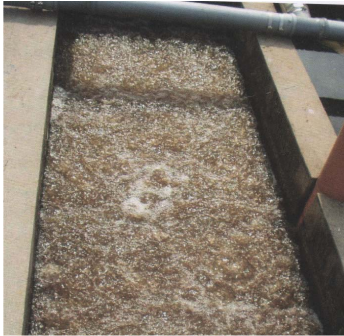
Рисунок 20_4.24 Промывка фильтра
