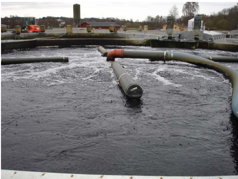
Рисунок 20_2.7 Биофильтр и подающий воздух трубопровод
