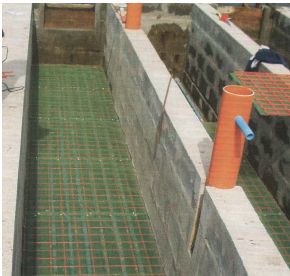
Рисунок 20_4.23 Распылители для промывки биофильтра с погружной загрузкой с монтированной поверх них сеткой для удержания биоагрузки
