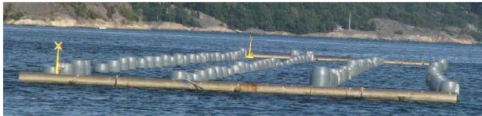
Рисунок 9.18 Установка из трубного каркаса, выполненного из нержавеющей стали, с четырьмя трубами длиной 120м.
