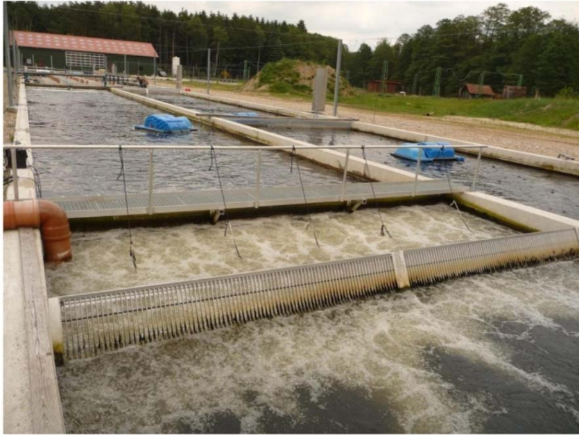
Рисунок 20_4.6 Работа эрлифта в действующих рыбоводных хозяйствах
