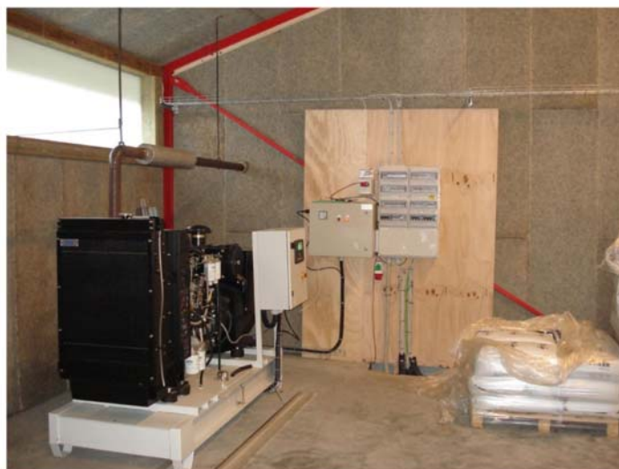
Рисунок 20_1.9 Щитовая и резервный генератор. Общее потребление энергии между 20 - 30 кВт. Основная плата, и резервный генератор, общее потребление энергии между 20 - 30 кВт
