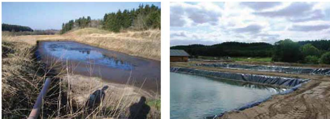
Рисунок 20_5.10 Из шламовых конусов, шлам поступает в бассейны/емкости для твердых частиц. Слева, образцовое форелевое хозяйство «Ejstrupholm» (Фото Alfred Jokumsen); справа образцовое форелевое хозяйство «Løjstrup».
