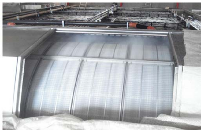
Рисунок 20_1.11 Барабанный механический микрофильтр Hydrotech с ячейей сетки 40 микрон
