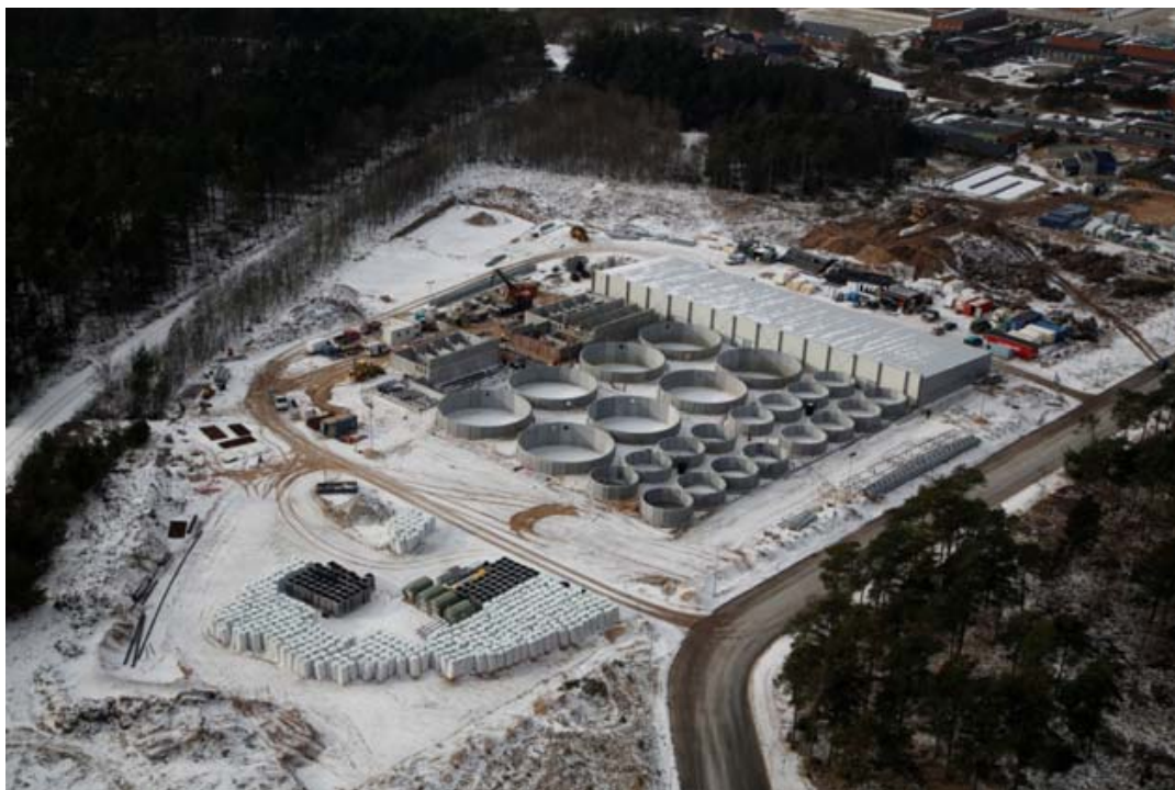
Рисунок 20_6.29 Строительство УЗВ с бетонными бассейнами круглой формы. Проектная мощность фермы – 4000 тонн в год. Максимальная плотность посадки в один большой бассейн – до 500 тонн на бассейн. Danish salmon, Хиртсшальс, Дания
