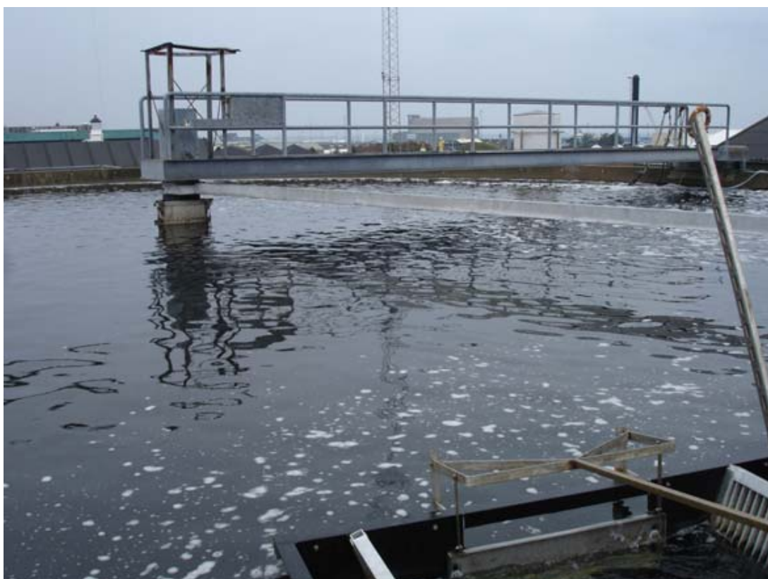
Рисунок 20_6.34 Модернизированный бассейн форелевой УЗВ. Институт водных ресурсов Датского технического университета, Хиртсшальс, Дания
