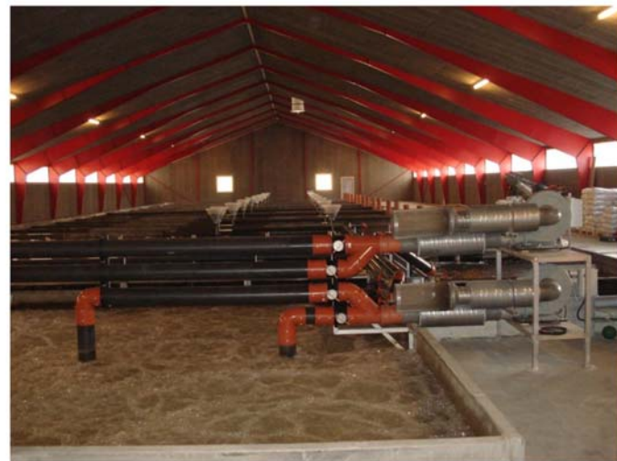
Рисунок 20_1.14 Дегазатор оснащенный воздуховкой VENTUR и системами трубопроводов
