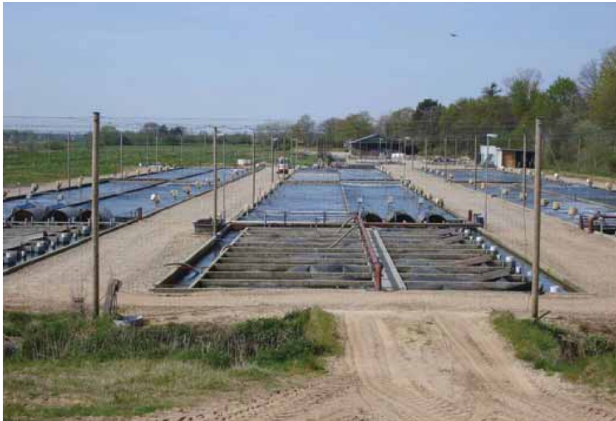
Рисунок 20_5.8 Образцовое форелевое хозяйство Kongeaens (тип 3). Производственные подразделения включают в себя три секции, каждая из которых состоит из двух бетонных дорожек с микро ситами (размер ячейки 74 мкм) перед секцией биофильтра (на переднем плане). Слева расположены биологические пруды, состоящие из бывших земляных прудов и впускных и выпускных каналов (Svendson et al., 2008).
