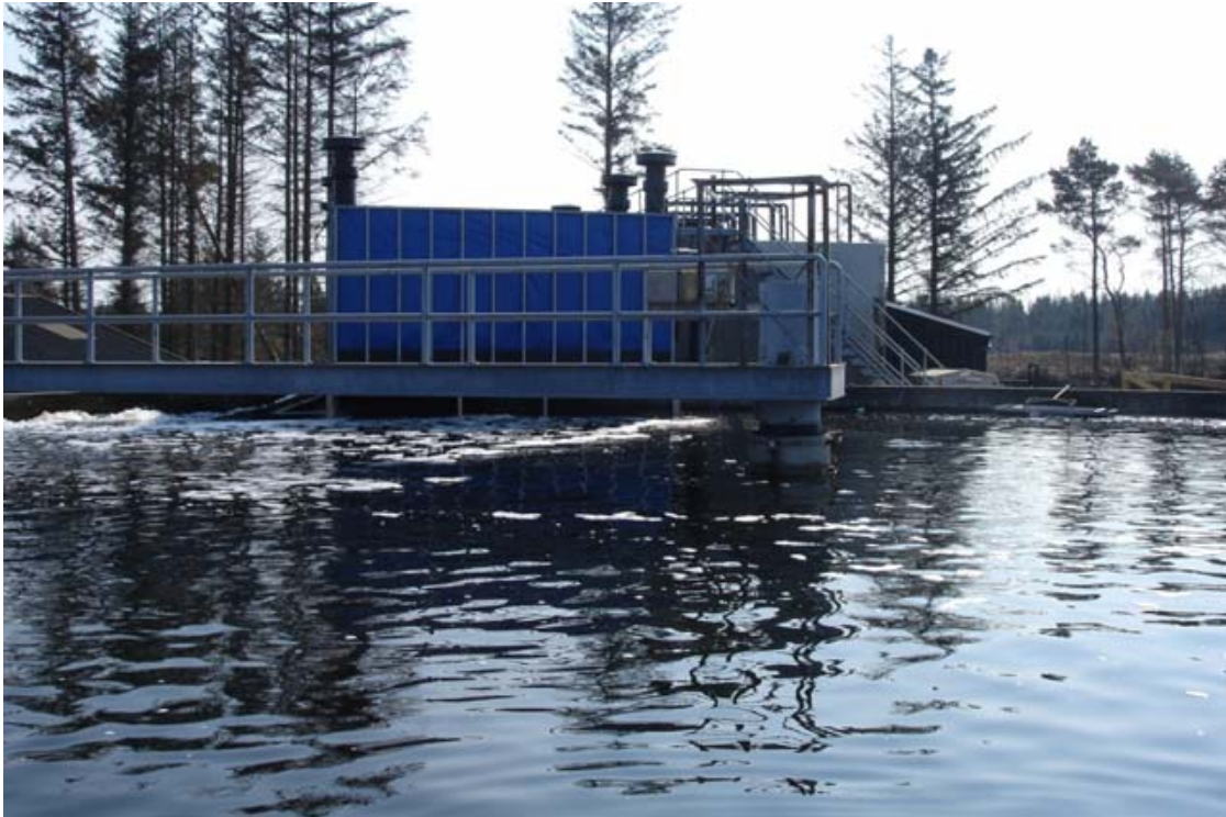
Рисунок 20_6.35 Биологический фильтр в виде пристройки к модернизированному бассейну форелевой УЗВ. Институт водных ресурсов Датского технического университета, Хиртсшальс, Дания
