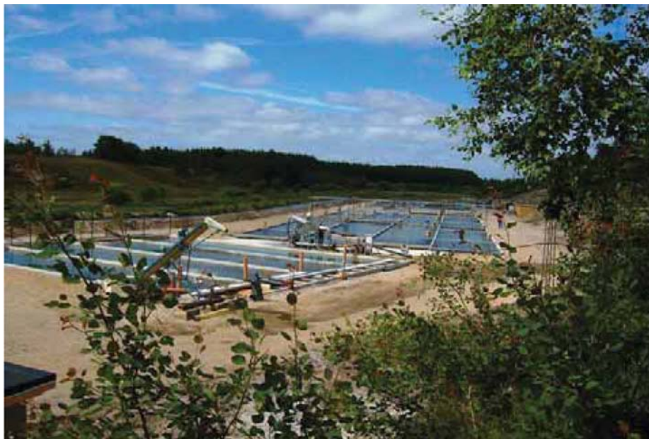
Рисунок 20_5.6 Образцовое рыбное хозяйство «Ejstrupholm» (тип 3). Производственные подразделения включают две секции, каждая из которых состоит из двух бетонных каналов. На переднем плане видны три пруда для содержания рыбы. На заднем плане, слева располагаются биологические пруды, которые состоят из бывших земляных прудов, заросших растениями.
