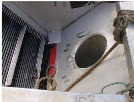
Рисунок 9.42 Трос протаскивающийся через трубку Вентури
