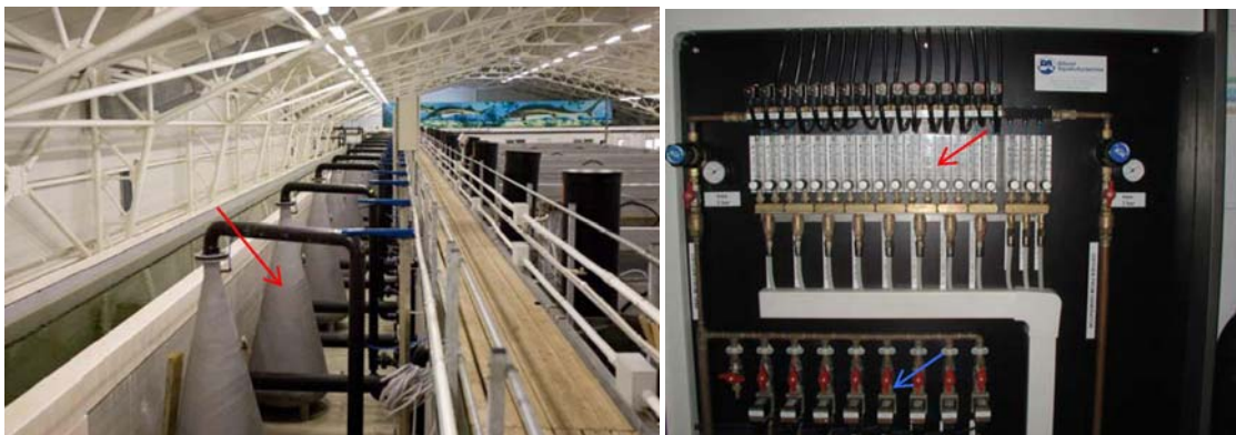
Рисунок 20_6.25 Система насыщения воды кислородом
