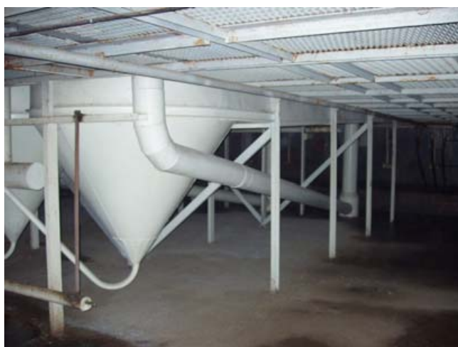
Рисунок 20_6.2 ЧПУП «Акватория» фермерского хозяйства «Василек» Дзержинского р-на. . Отличительной особенностью данной УЗВ являются стальные бассейны, с наклонным дном и конусом, для сбора шлама, а также эрлифты для дополнительной циркуляции и аэрации воды
