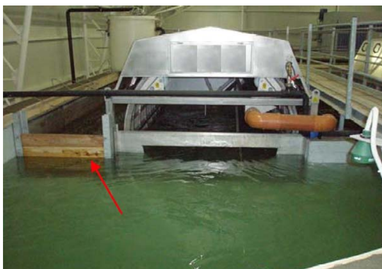
Рисунок 20_6.22 Механический фильтр. Стрелкой указан шандорный перелив (в случае аварии)
