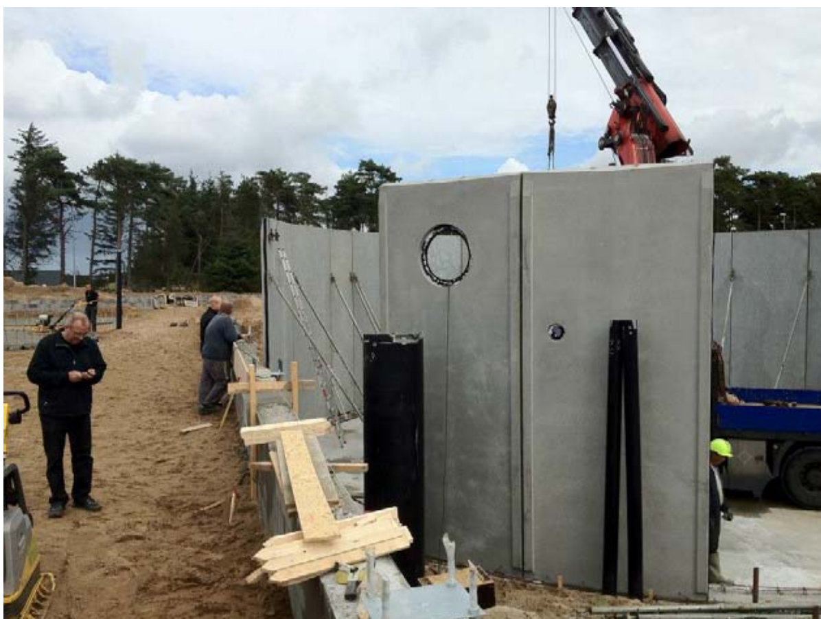
Рисунок 20_6.30 Монтаж бетонного бассейнами круглой формы. Danish salmon, Хиртсшальс, Дания
