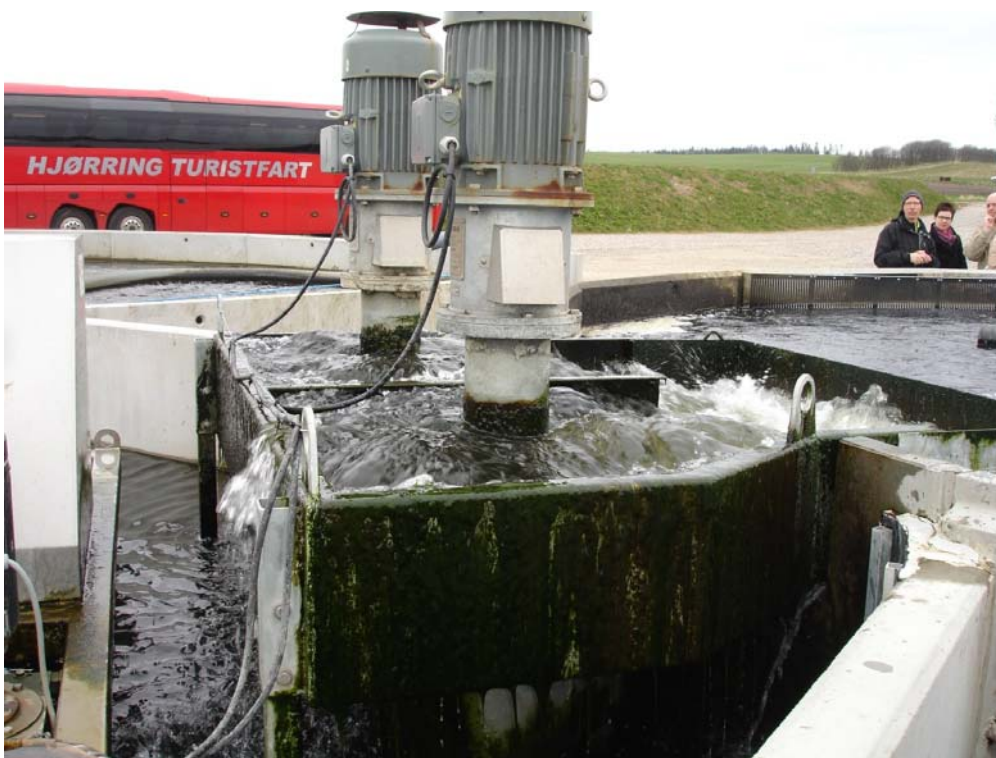
Рисунок 20_2.6 Два насоса для платформ с инжекторами
