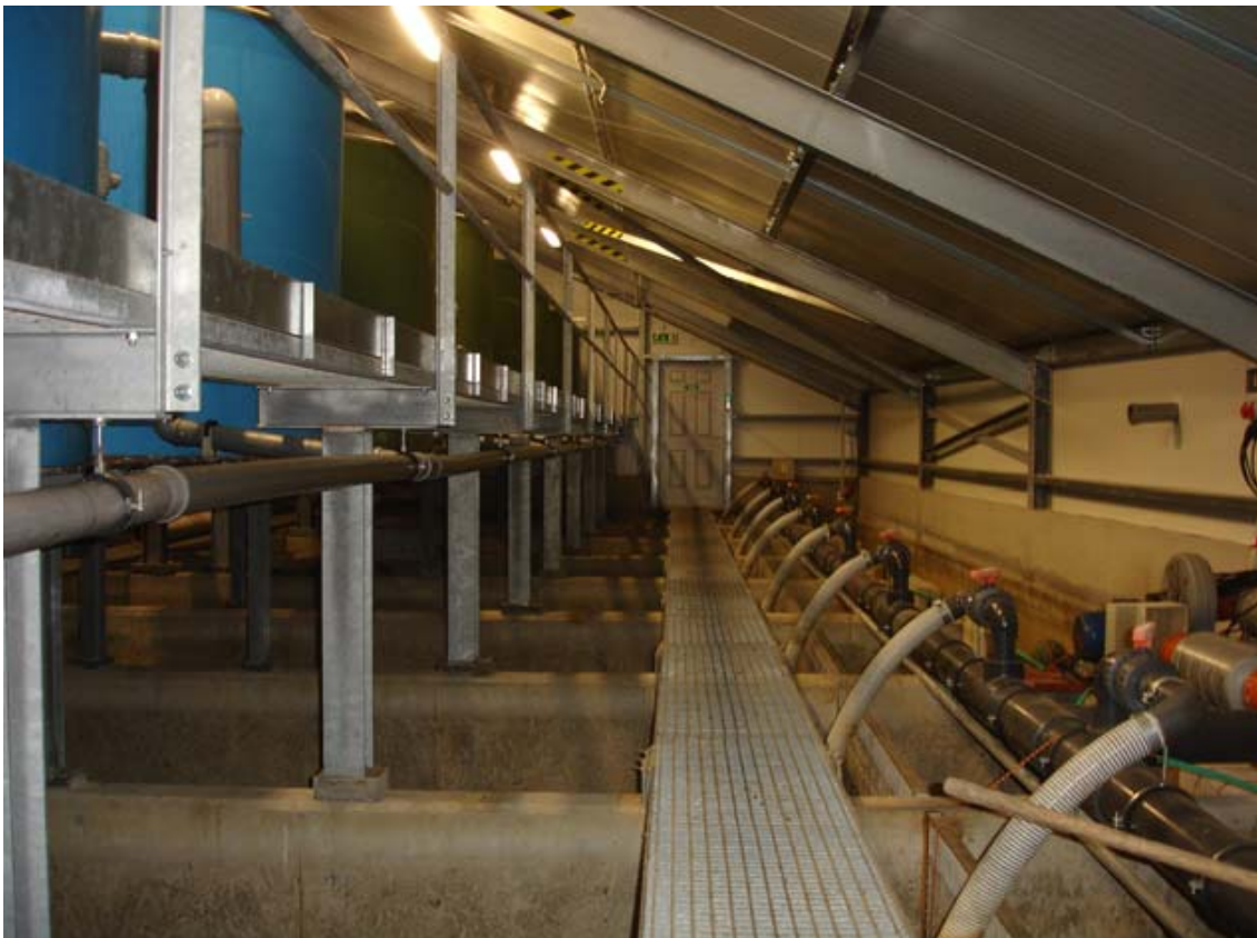
Рисунок 20_6.36 Комбинированная (двухэтажная) УЗВ из Чехии: первый уровень – каналные бетонные бассейны для выращивания товарной рыбы, второй уровень – круглые бассейны для выращивания мальков
