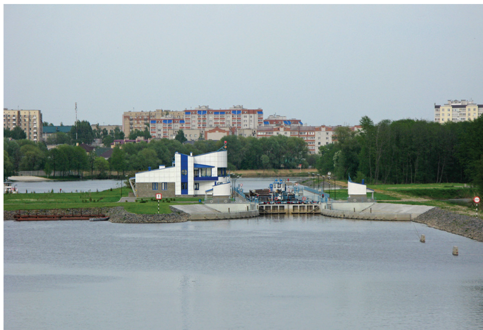
Рис. 3.3. Днепровско-Бугский канал, гидроузел № 10 «Тришин», г. Брест
