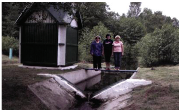
Рис. 2.25. Водослив с треугольным вырезом гидрологического поста на ручье без названия в г. п. Нарочь
