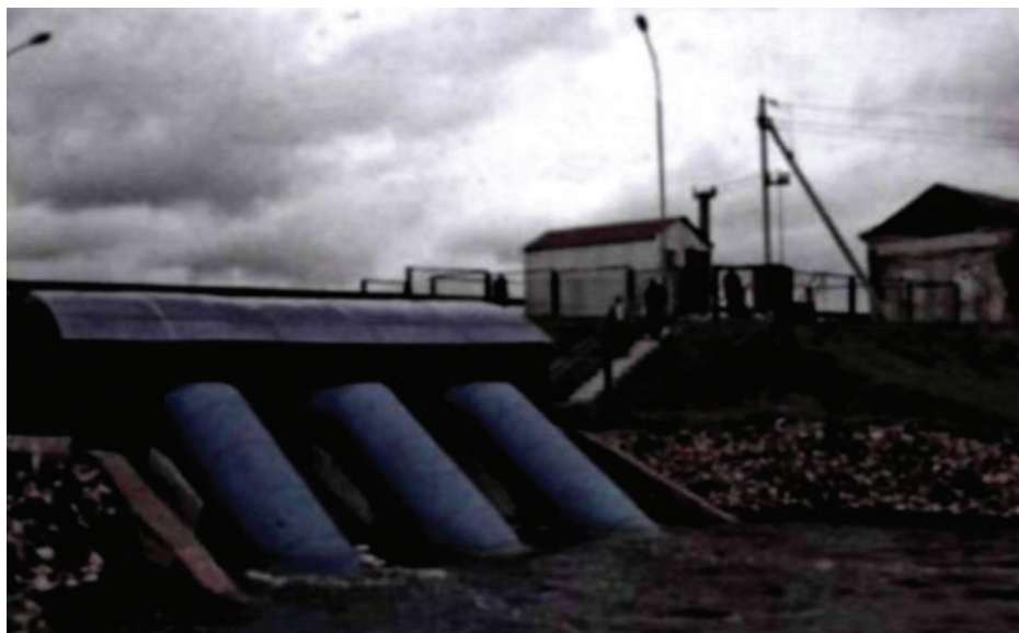
Рис. 2.7. Плотина Саковщинского водохранилища на р. Западная Березина
