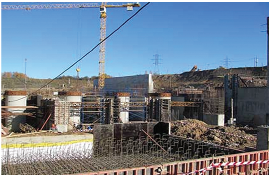
Рис. 3.8. Здание Полоцкой ГЭС и подводящий канал (вид с верхнего бьефа)
