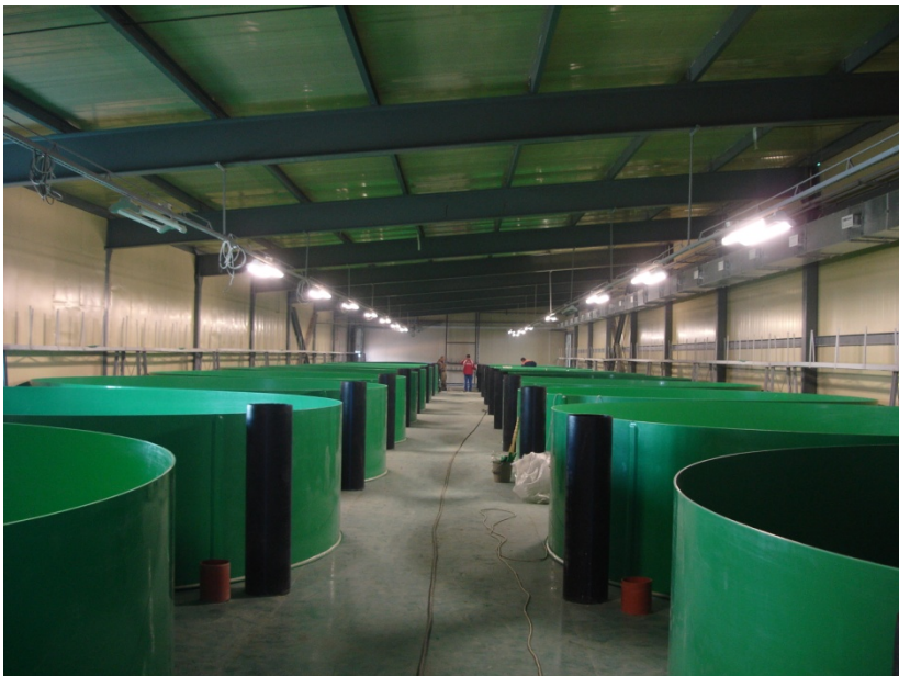
Рис. 2.6. Монтаж модуля выращивания молоди до 50 г
