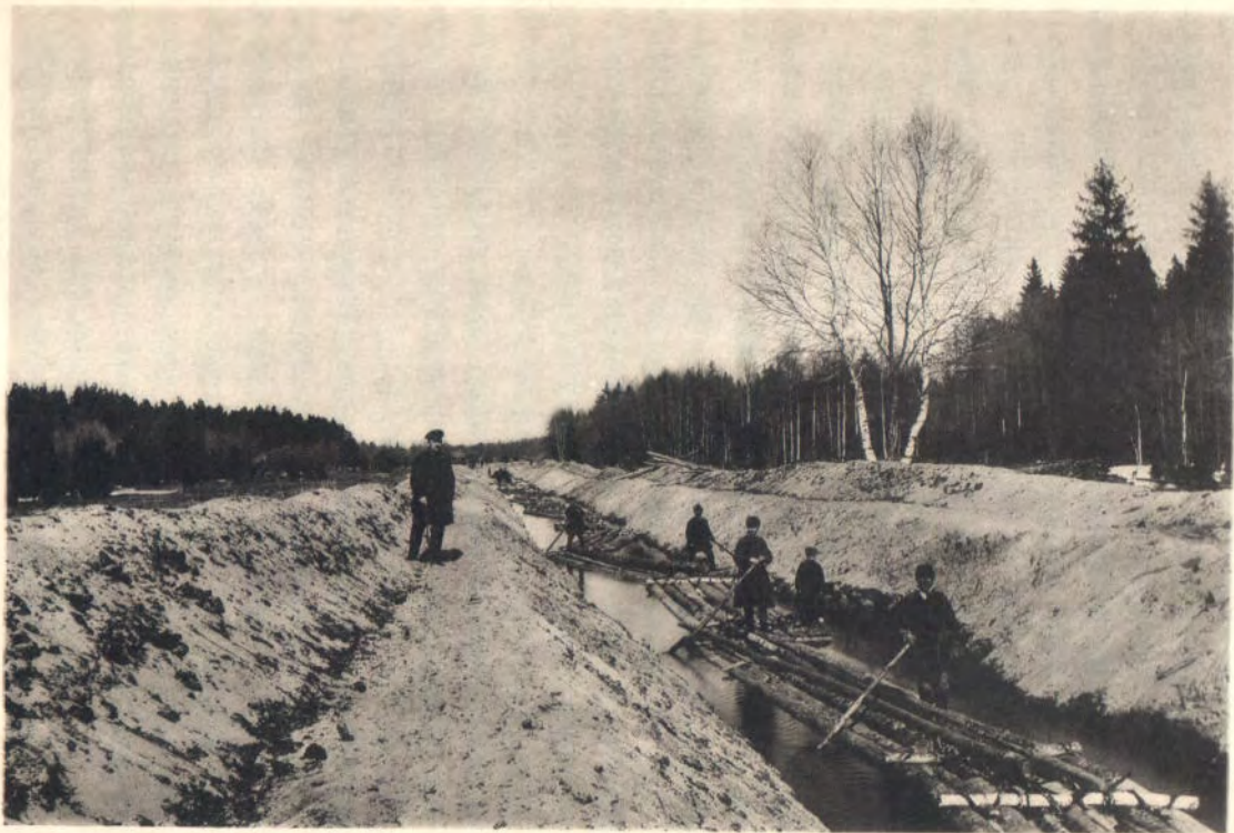
Славъ лѣса по Воронцовскому каналу.
