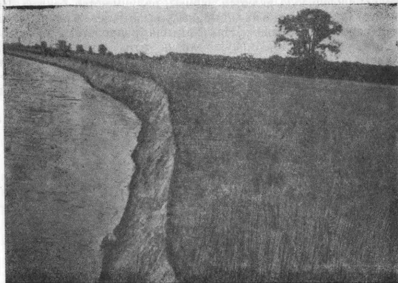
Рис. 25 Размыв Припятью правого берега
