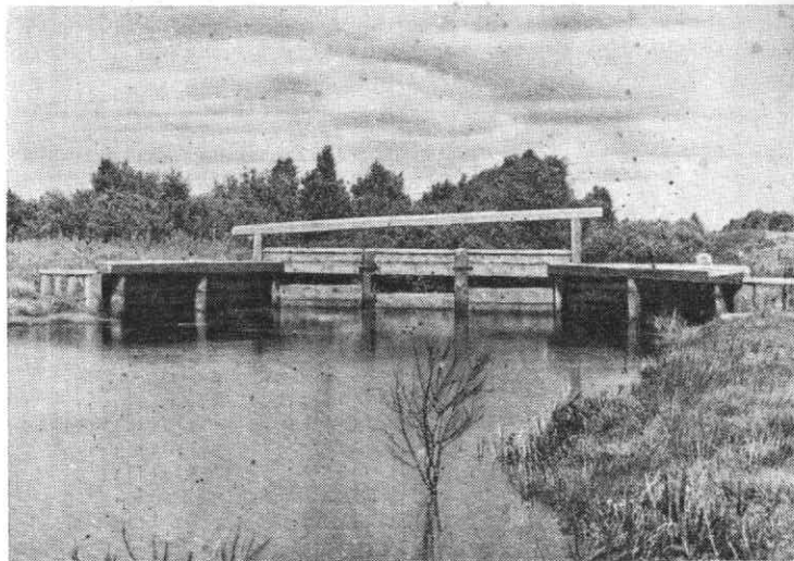
Рис. 4. Шлюз на магистральном канале Выгоновского болотного массива
